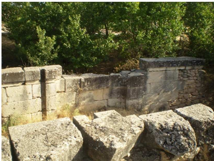
Restos del Canal del Gran Prior a su paso por Villacentenos
