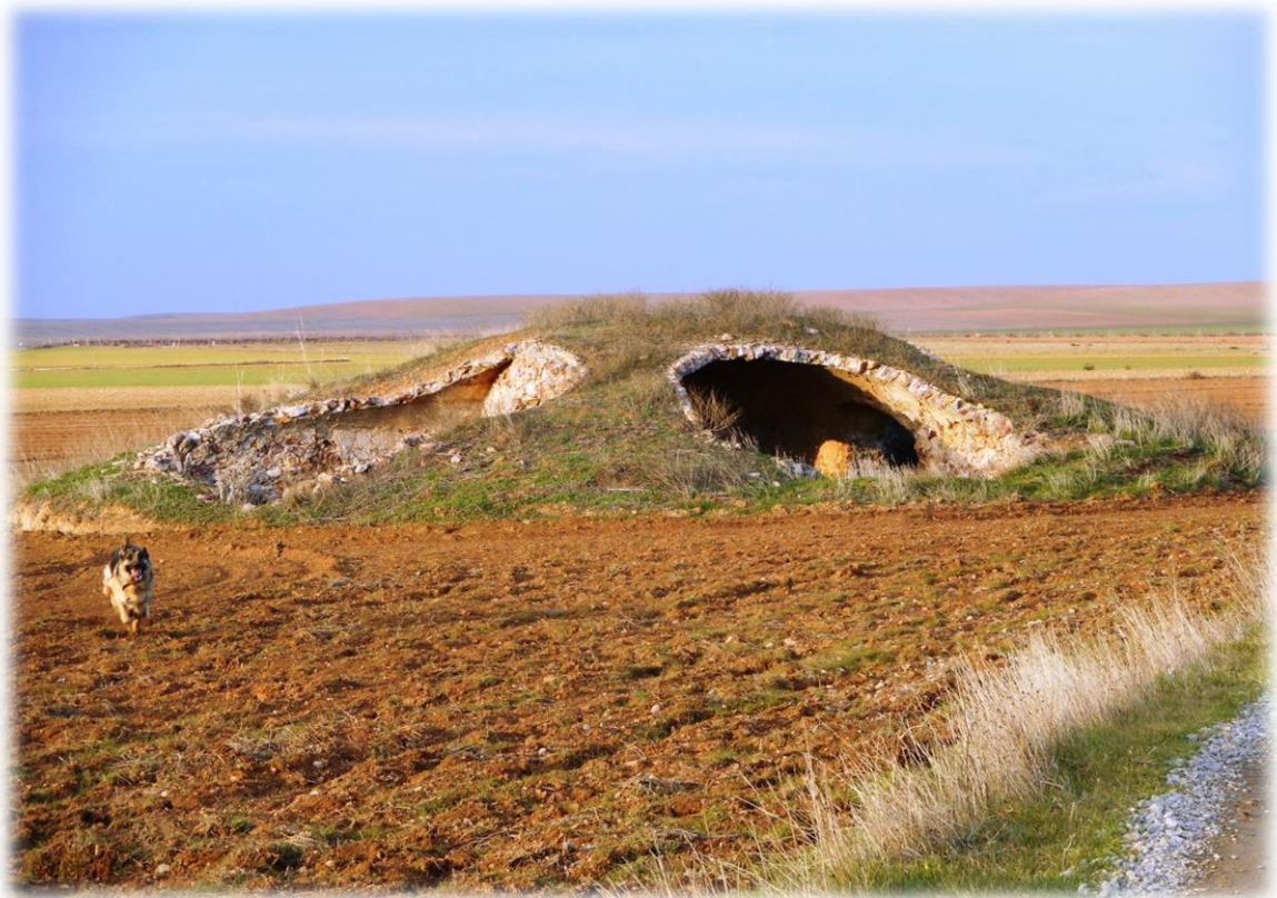
Silo "Tipo B"
